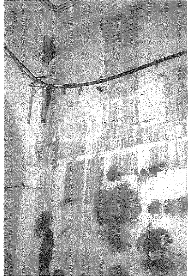
(D) Concrete patch repair
